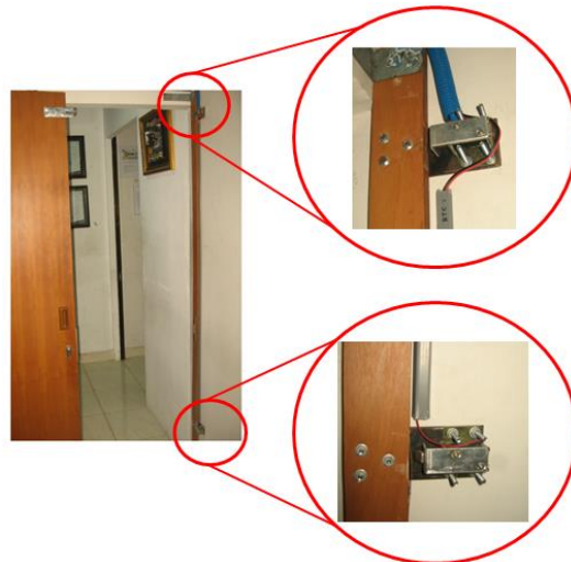
Gambar 9. Posisi Peletakkan Electric Locker
